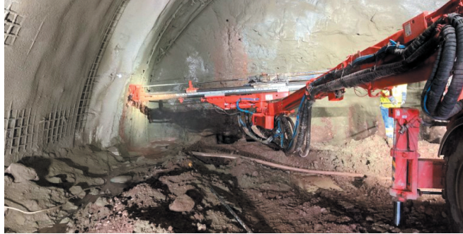
Rys. 9. Wykonanie obudowy wstępnej (tu: montaż kotwi skalnych) [3]
