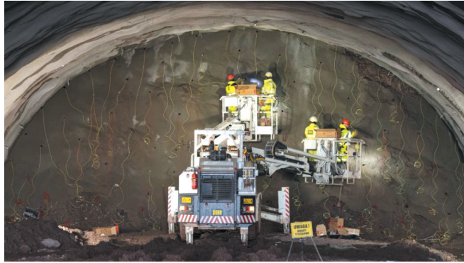
Rys. 8. Zakładanie materiałów wybuchowych [3]
