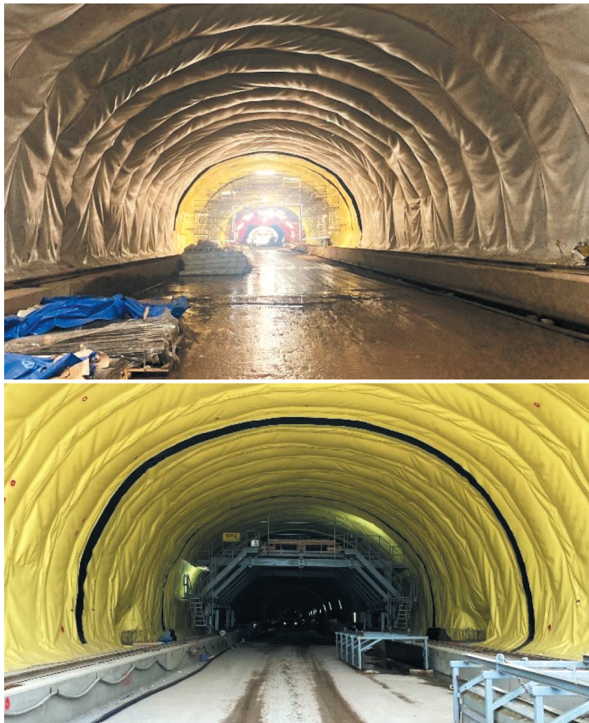
Rys. 13. Wykonanie hydroizolacji: warstwa ochronna z geowłókniny, membrana PVC [3]
