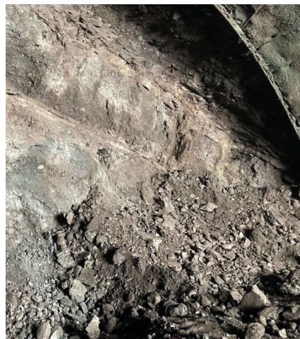
Rys. 10. Monitoring geologiczny: a) dokumentacja geologiczna kartowania czoła przodka; b) dokumentacja fotograficzna [3]
