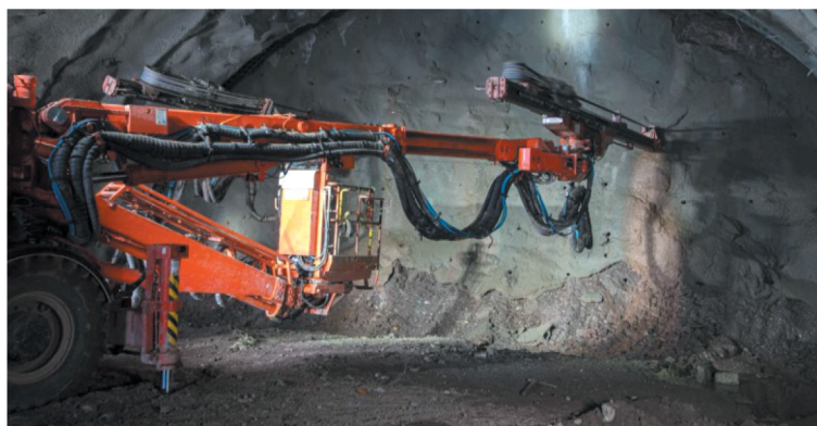
Rys. 7. Wiercenie otworów strzałowych [3]
