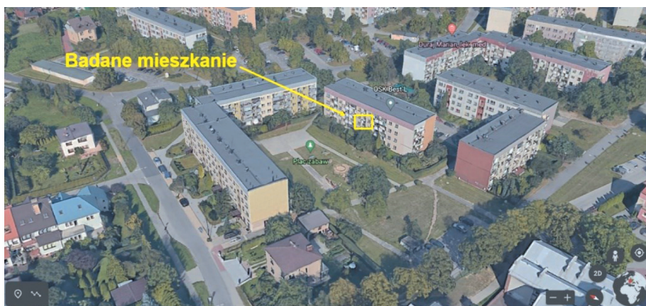
Rys. 1. Usytuowanie budynku ze wskazaniem badanego pomieszczenia
