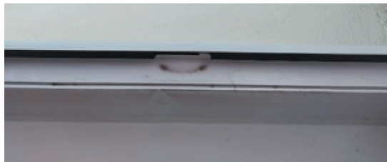
Rys. 14. Górna część ościeżnicy drzwi balkonowych z częściowo wyciętą uszczelką
