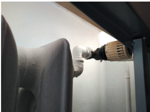
Rys. 19. Widok I na głowicę termostaticzną grzejnika członowego i jej okolice
