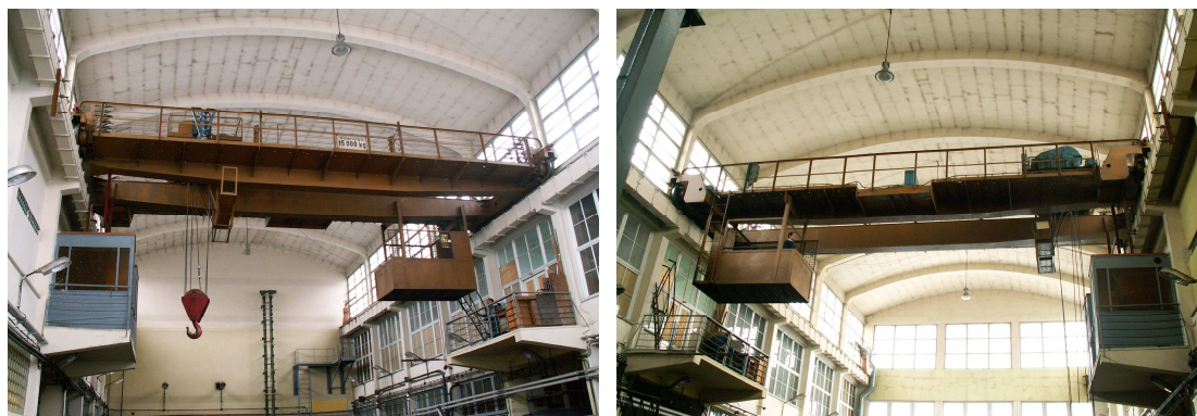
Rys. 3.26. Ogólny widok badanego obiektu
