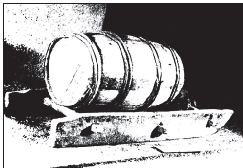
Rys. 132. Sanie do transportu poziomego beczek i bałwanów [152]
