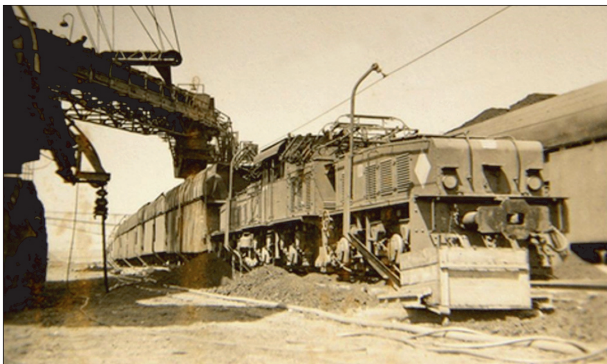
Rys. 397. Transport szynowy współpracujący z koparką – lata 30. XX wieku [40]
