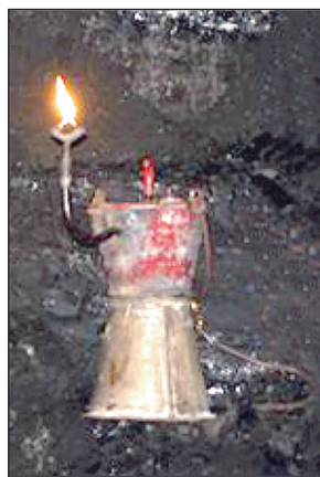
Rys. 179. Lampa karbidowa z końca XIX wieku
