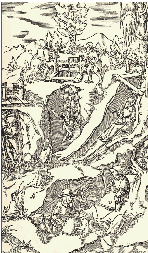
Rys. 91. Szyb jednoprzędziowy i pochyły [1]
