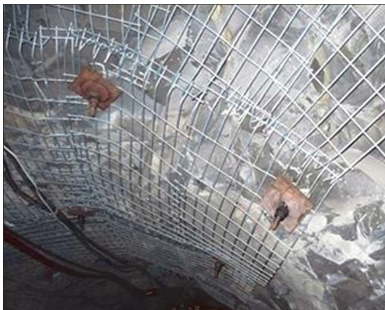
Rys. 277. Widok zakotwionego stropu [38]
