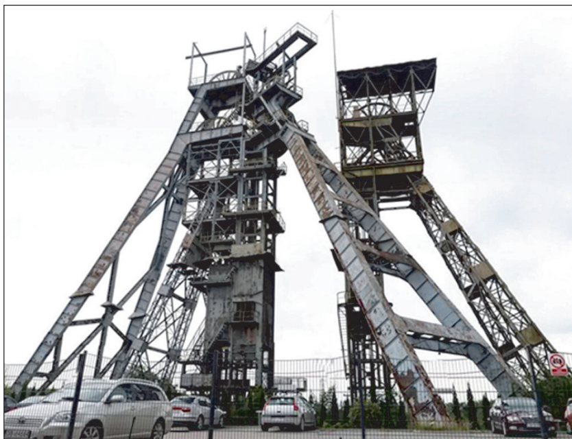
Rys. 167. Wieże szybowe metalowe, piramidalna (z lewej), z podporami (z prawej) [56]
