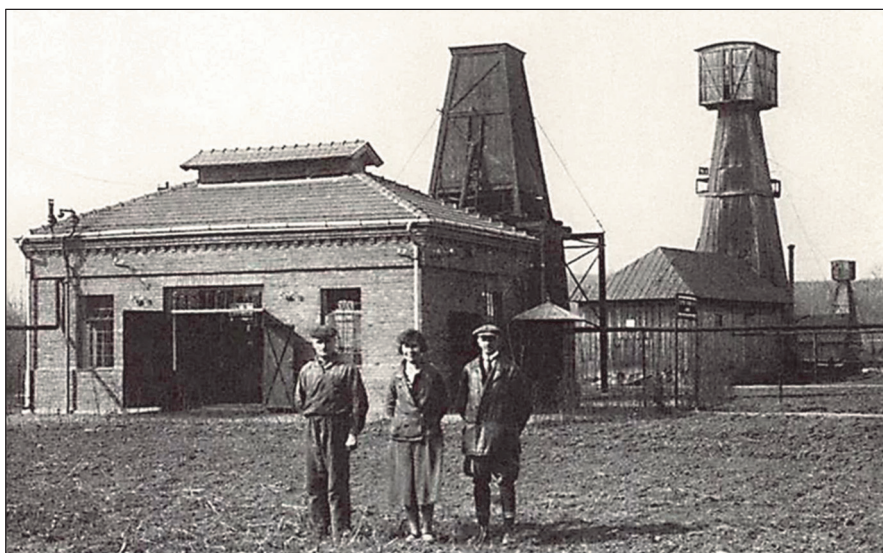
Rys. 430. Szyb gazowy i sprężarnia (lata 20.) [198]
