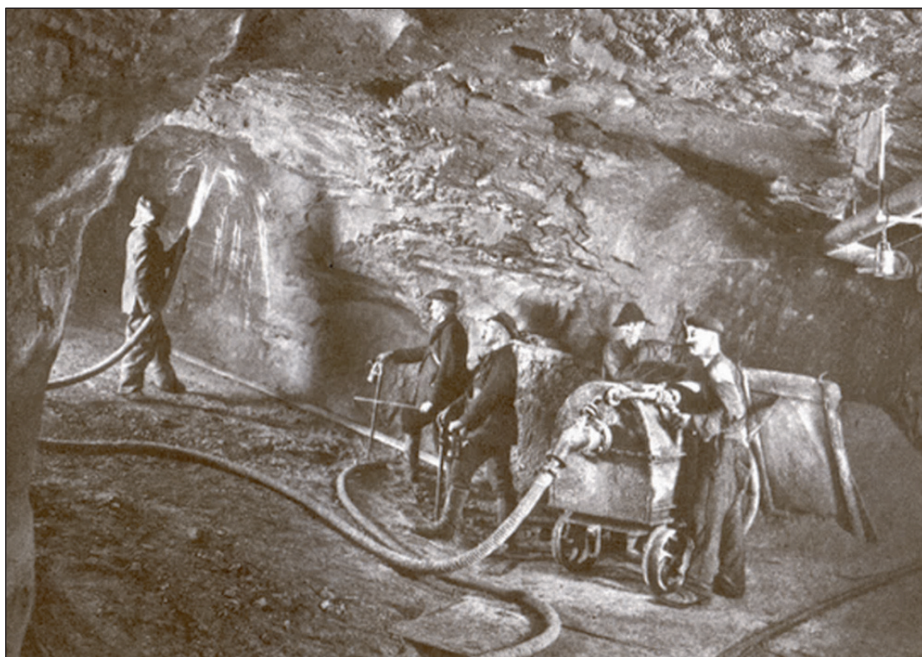
Rys. 278. Zastosowanie torkretu w kopalni [30]
