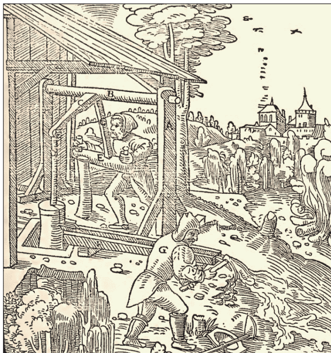
Rys. 113. Pompa tłokowa [1]
