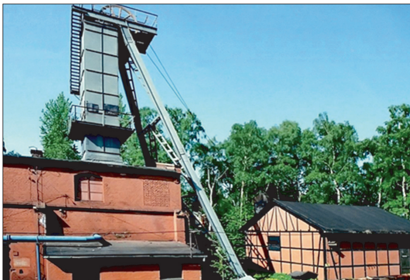
Rys. 168. Wieża szybowa z podporami z budynkami nadszybia i maszyny wyciągowej [54]
