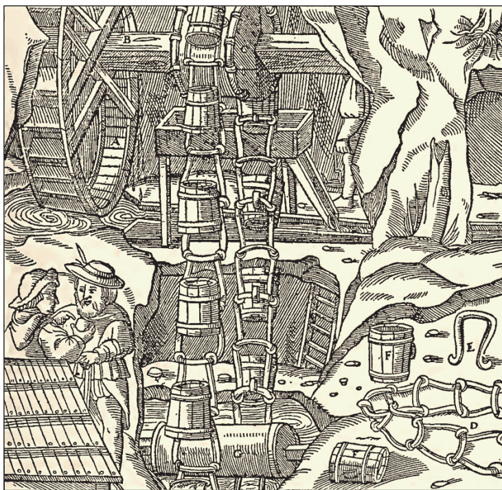
Rys. 112. Podnośnik kubełkowy [1]
