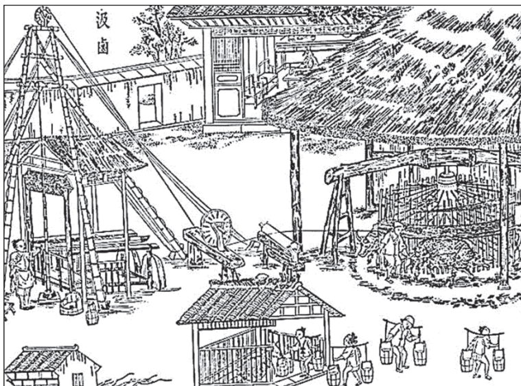
Rys. 81. Wiercenie uderowe, żerdziowe – stan techniki ok. 600 lat BC [3]
