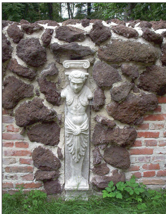
Rys. 84. Fragment muru z wbudowanymi bryłami rudy darniowej [113]
