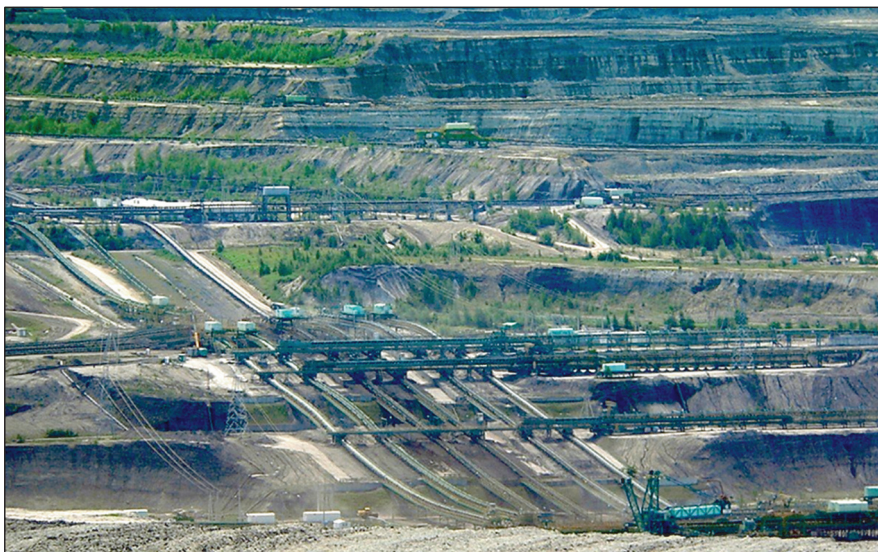
Rys. 398. Układ taśmociągów transportujących węgiel brunatny – KWB Turów
