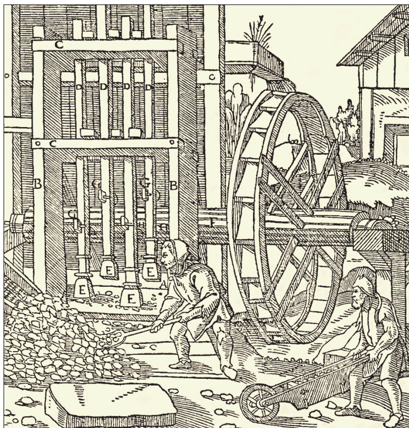
Rys. 121. Stępor mechaniczny (kruszenie na sucho) [1]
