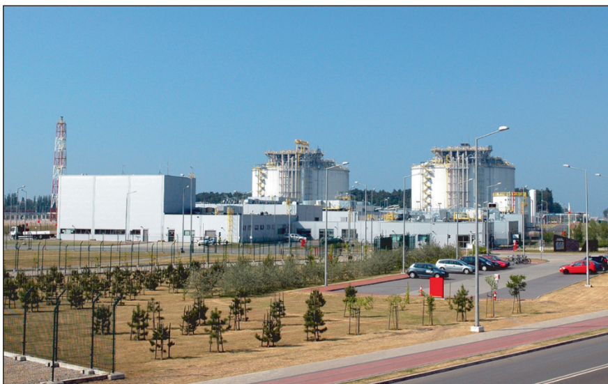
Rys. 434. Terminal gazowy w Świnoujściu [118]
