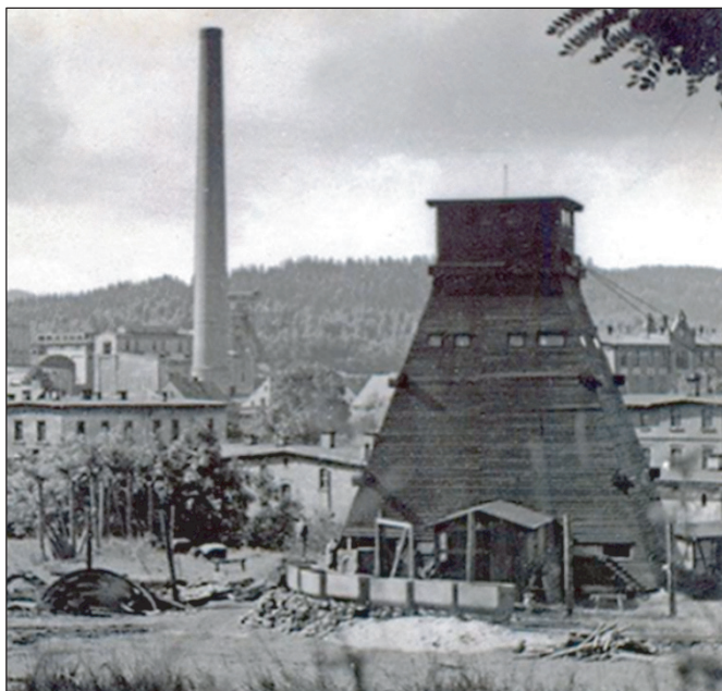
Rys. 166. Wieża szybowa drewniana [54]
