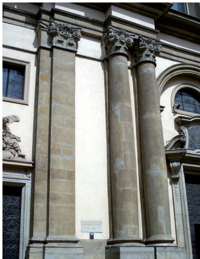
Fig. 3. The SE façade of the church – the plinth made of the Istebna Sandstone ashlars, the stars cut of the Cretaceous Quader Sandstone, phot. M. Florczyk • Elewacja SE kościoła – cokół z ciosów piaskowca istebniańskiego, schody z kredowego piaskowca ciosowego, fot. M. Florczyk
