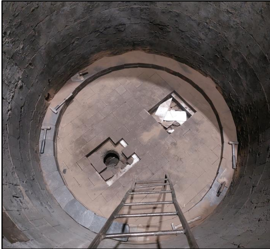
Rys.60. Zabudowa pierścienia startowego ściany kadzi głównej.
