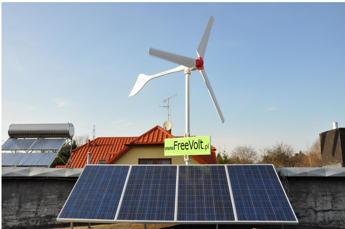
Rysunek 5 Przykład przydomowej, hybrydowej elektrowni słoneczno-wiatrowej
